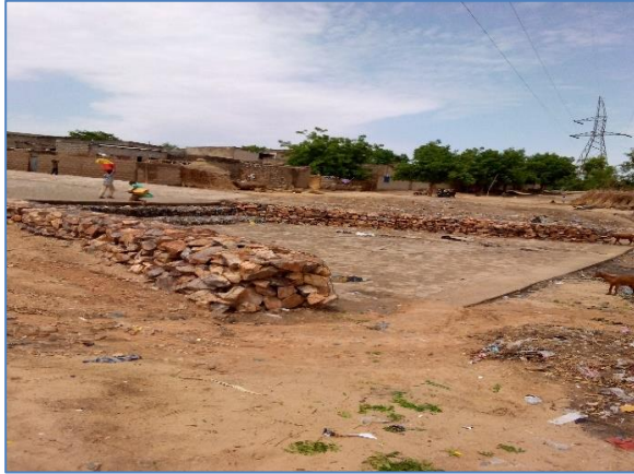
Figure 4. Pavé stabilisé à l'exutoire
