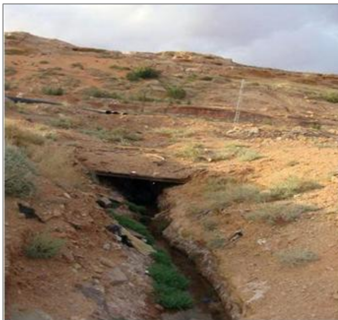
Figure 3. Sortie d'une foggara de Kenadsa. Mars 2013 [7]
